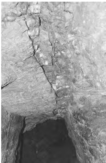
Obr. 2. Křemenná žila ve stropě krátké štolky založené v počvě „Zelené jámy“. Foto M. Nepejchal.
