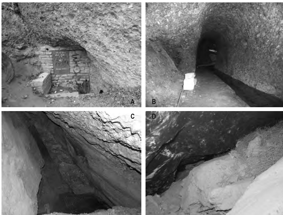
Obr. 3. A - ústí štoly, B - vybetonovaná hlavní chodba s odvodňovacím žlábkem, C - volná prostora sledující zlomové pásmo průběhu sz.-jv., D - zával v zatopené části štoly.
